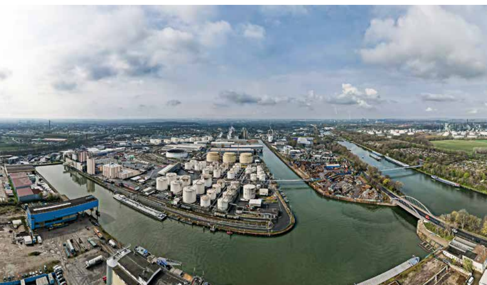
Fig. 1: Klimahafen Gelsenkirchen [Source: Julian Schäpertöns]
